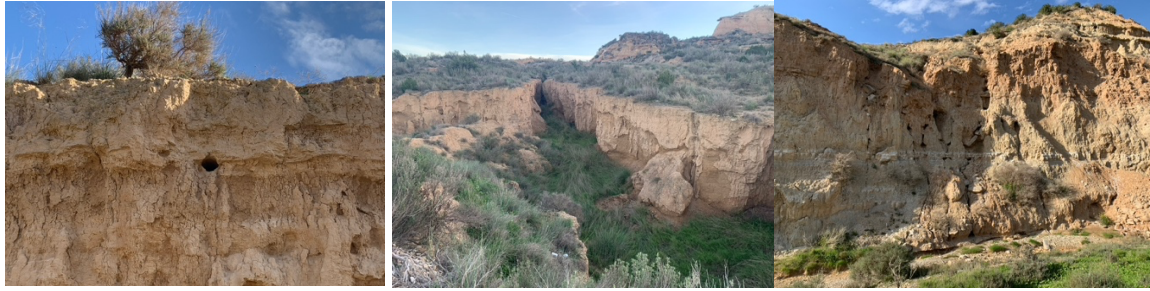
Fig 2. Petit « pipe » dans les sols du massif de Monegros, ravine produite par effondrement d'un conduit d'érosion par soutirage profond, et pipes multiples le long d'un berger.
